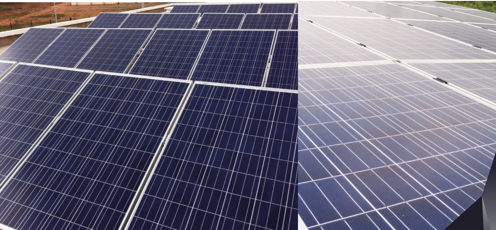
Réalisation d'une centrale photovoltaïque de 75 kVA connectée au réseau
