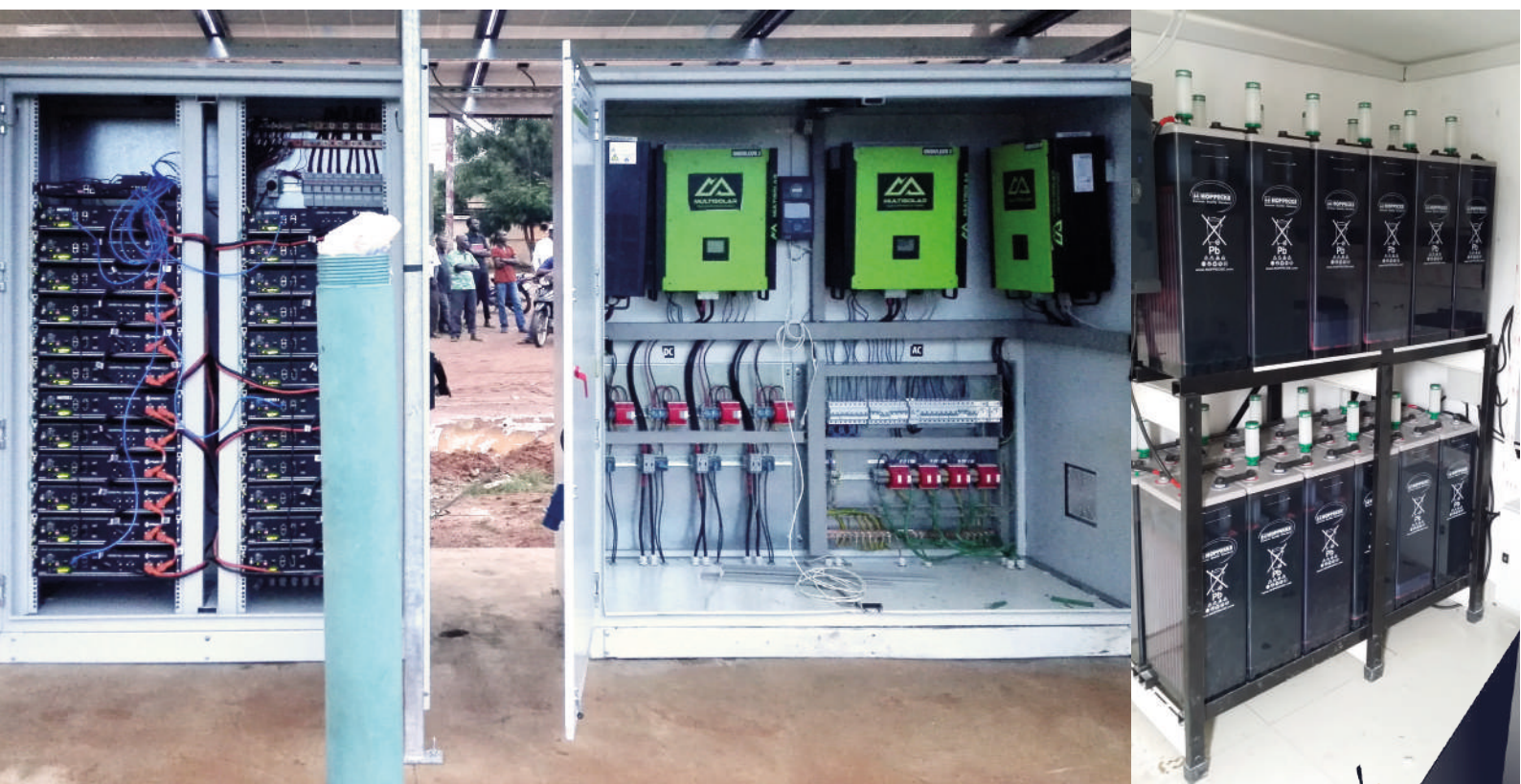
Installation de parcs de batteries
